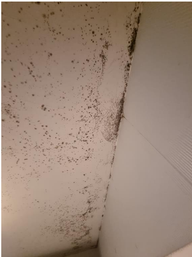
Foto's van schimmel op raam van de slaapkamer:
