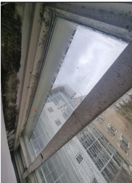
Foto's van schimmel op raam van de slaapkamer:
